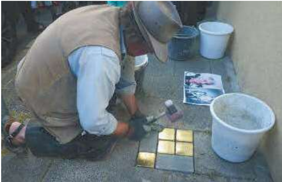
Verlegung der Stolpersteine für Familie Isserlin. (Foto: Sven Hammerbeck)
